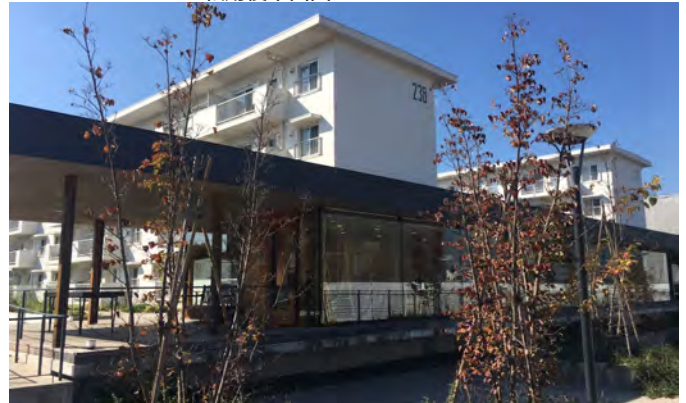
外観（手前：食堂兼多目的室 奥：サ高住）
